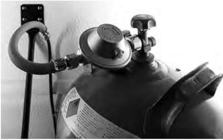
Anschluss des Gasreglers an der Gasflasche
